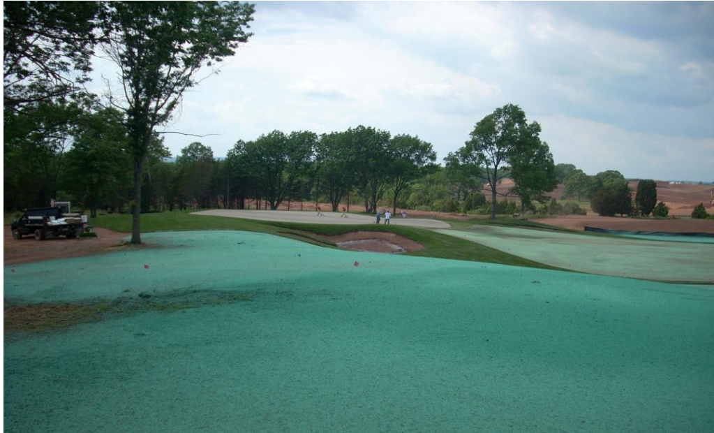
Рис. 4.12. Спосіб влаштування газону за допомогою спеціальної установки, з рідкою сумішшю добрив, насіння газону, синтетично стабілізуючого розчину (латексу), насоса для розпилювання рідкої суміші по поверхні ділянки.
