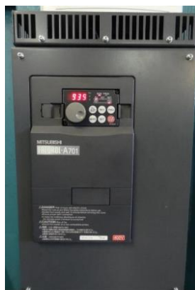
Рисунок 3.3 - Перетворювач частоти Mitsubishi FR-A741-5,5К.
