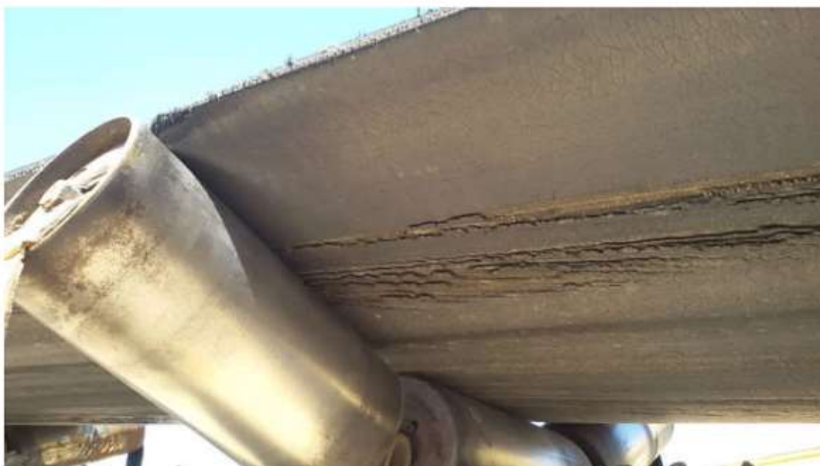
Рис. 1.15 - Порізи на конвеєрній стрічці (на фото стрічковий конвеєр, транспортування гравію)
