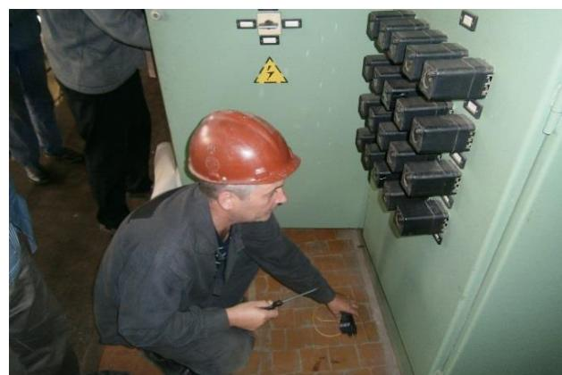
**7.3.2.2** Провести внутрішній огляд, чистку та перевірку механічної частини апаратури.
