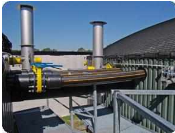
Аварійний клапан збросу біогазу
