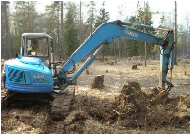
Рис. 1.1.1.2.Механізований процес корчування пеньків
