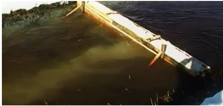
Рис. 1.3.1.1.4. Ємкості з негашеним вапном на водонапуску
