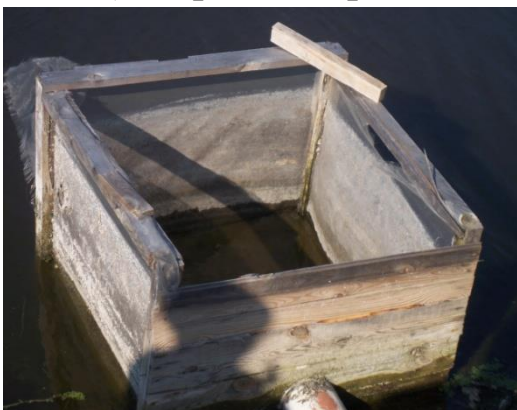
Рис. 1.3.1.1.1. Механічні фільтри ставів:
