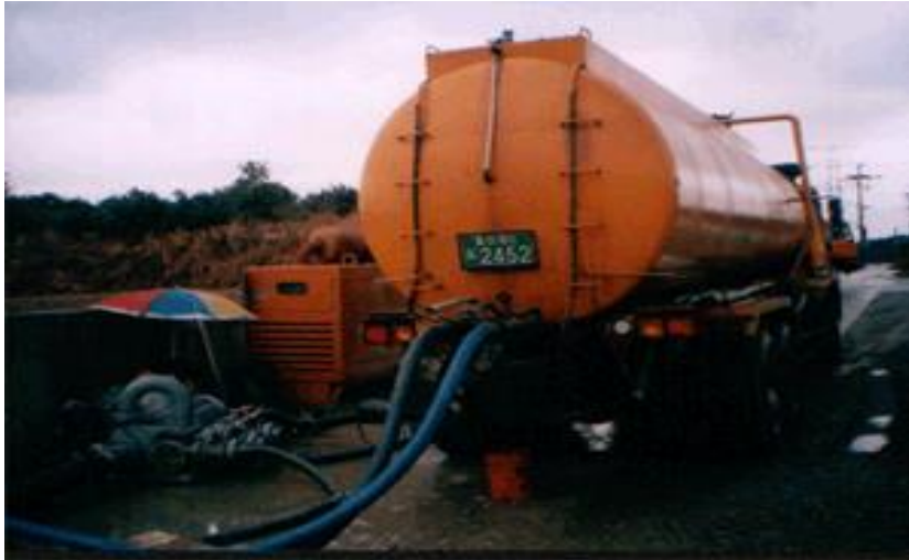
Рис. 1.2.1.4. Берегова землевсмоктуюча установка
