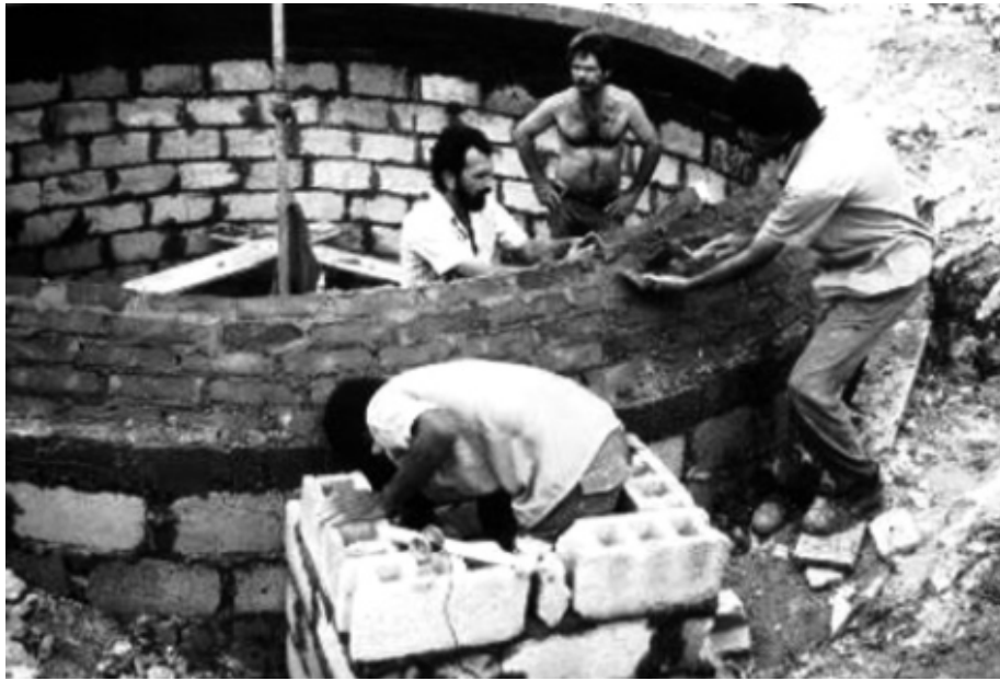
Рис. 5. - Побудова цегляного реактора
